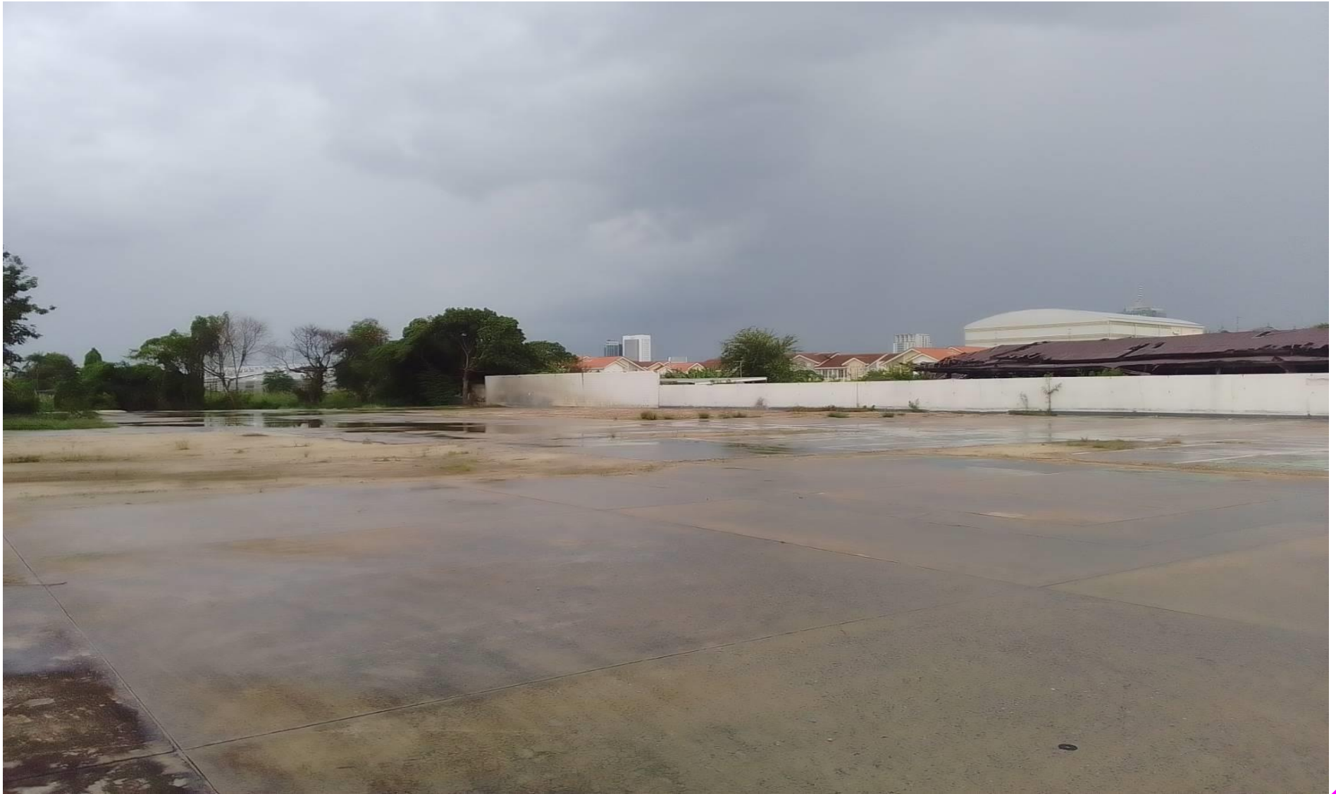
ภาพที่ 2-พื้นที่ด้านในที่ดินโซนด้านหน้าเป็นพื้นคอนกรีตหนา 0.20 ม.
