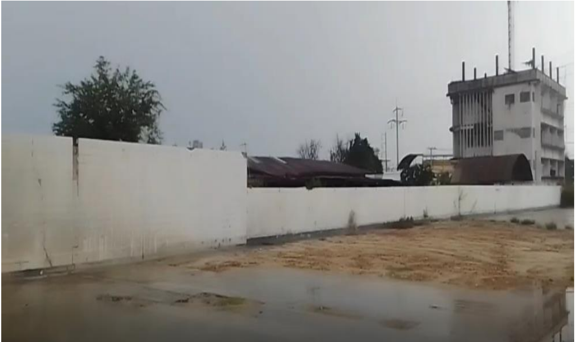
ภาพที่ 5-พื้นที่ด้านข้างมีรั้วคอนกรีตโดยรอบพื้นที่
